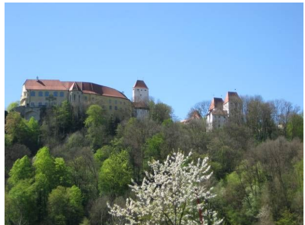
© Aconcagua Abb. 35: Heutige Ansicht von Schloss Neuburg am Inn
