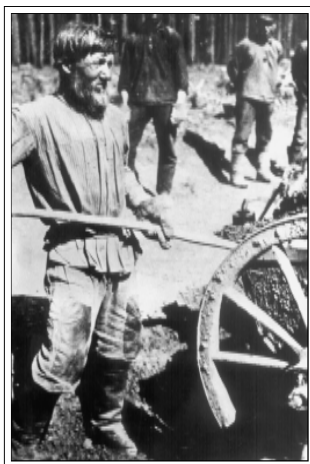
Строительство Уралмаша. 1927 г.
