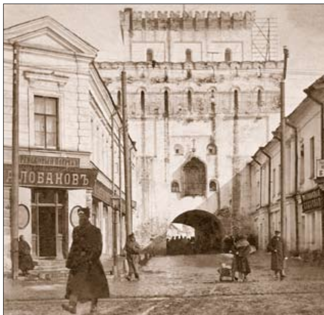
Власьевская башня. Западный фасад. Начало XX века
