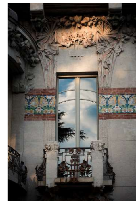
Balcony on the main facade of Villa Bernasconi Balcó de la façana principal de la Vil·la Bernasconi
