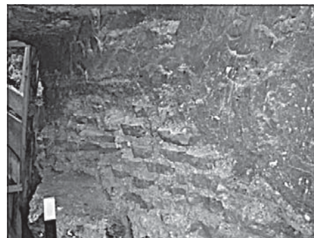
Рис. 1. Давньоруські мурі КПЛ. Загальний вигляд
