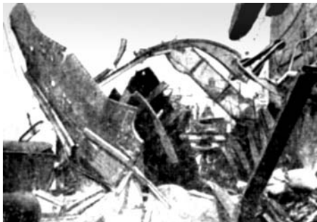
Разрушения левого борта и палубы крейсера в результате попадания авиабомбы 2 июля 1942 г.
