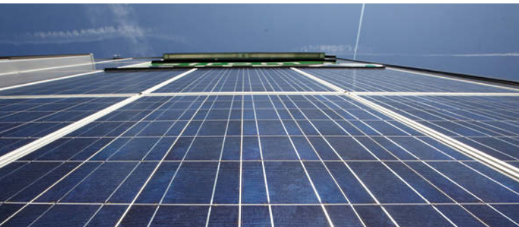
Foto: Klima- und Energiefonds/Ringhofer
