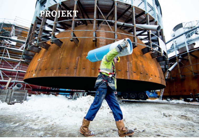
Bau des Hochdruck-Wärmespeichers, Quelle: Wien Energie/Ian Ehm
