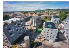
Stadtwerk Lehen, Foto: Stadt Salzburg
