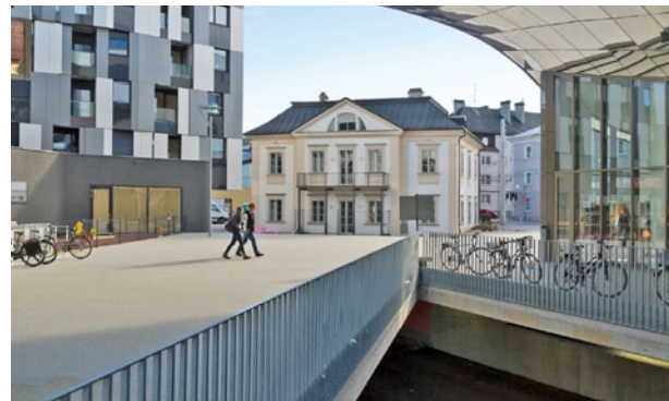
Stadtwerk Lehen, Salzburg, Foto: PRISMA
