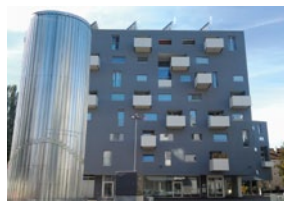
Stadtwerk Lehen - Solarspeicher, Foto: SIR
