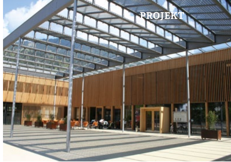
Gemeindezentrum Ludesch mit Glas/Glas Modulen gefertigt von ertex-solartechnik GmbH, Foto: GR Gebhard Bertsch
