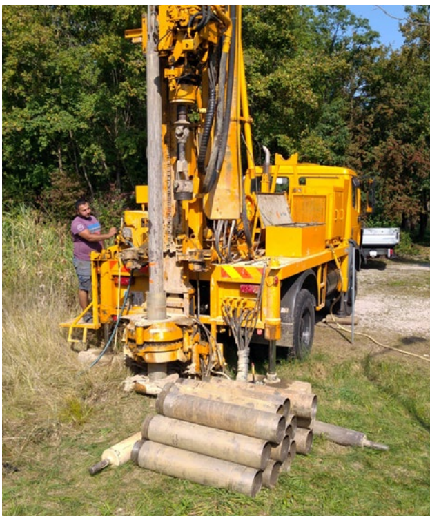
Zweite Bohrung am NÖM-Gelände im September 2020. Diese Bohrung wurde als Kernbohrung bis zu 30 m Tiefe durchgeführt, Foto: Projekt SANBA
