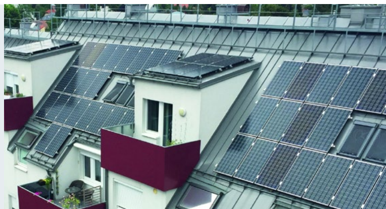
PV-Anlage Wien Stammersdorf, Foto: PV Austria
