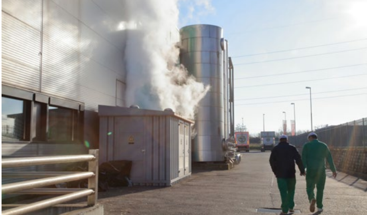
Industrielles Energieversorgungssystem eines Projektpartners; links: Thermische Speicher; rechts: Wärmeerzeuger und -verteilsystem; Fotos: Klima- undEnergiefonds/Krobath
