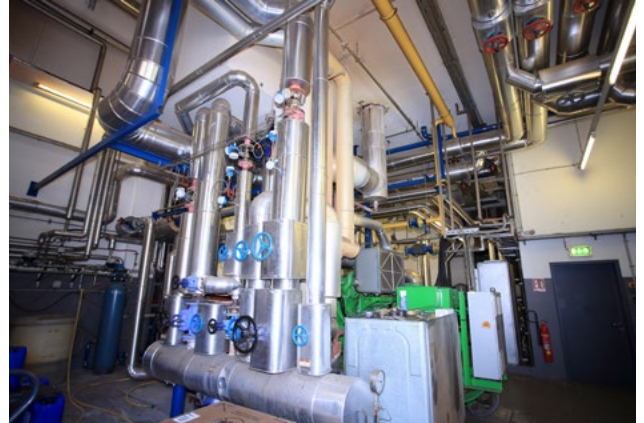
Industrielles Energieversorgungssystem eines Projektpartners; links: Thermische Speicher; rechts: Wärmeerzeuger und -verteilsystem; Fotos: Klima- undEnergiefonds/Krobath
