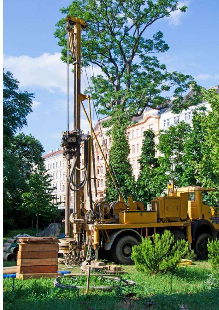
Bohrung der Test-Erdwärmesonde, Foto: Heat Harvest-Konsortium
