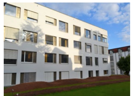
von oben nach unten: Kindergarten St. Paulus, Foto: NEUE HEIMAT TIROL Gemeinnützige Wohnungs GmbH; Messequartier Graz BA1, Foto: Gem. Wohn- u. Siedlungsgenossenschaft Ennstal reg. Gen.m.b.H.; Seniorenwohnhaus Itzling, Haus 4, Foto: Stadt Salzburg, Marko Herold; Kinder- und Herzzentrum Innsbruck, Foto: Gerhard Berger; St. Josef Krankenhaus, Bauteil 10, Foto: Ing. Mladen Velic
