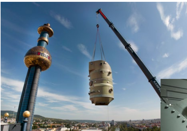
Bau einer Großwärmepumpe in der Müllverbrennungsanlage Spittelau, Fotos: Wien Energie/Johannes Zinner
