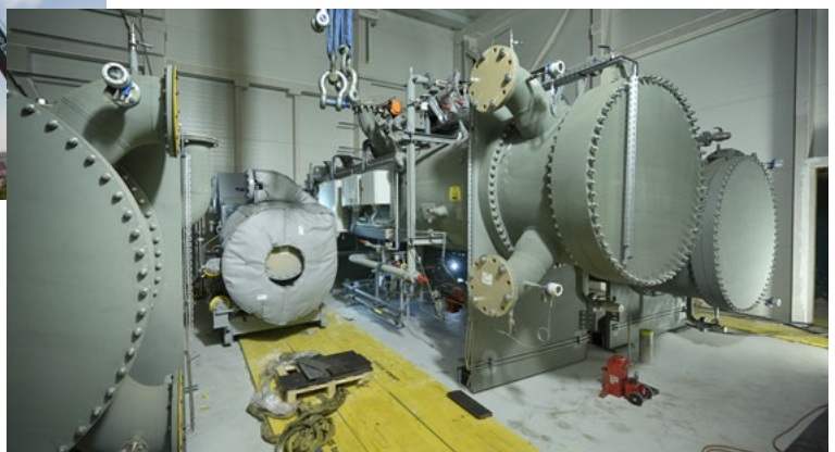
Bau einer Großwärmepumpe in der Müllverbrennungsanlage Spittelau, Fotos: Wien Energie/Johannes Zinner
