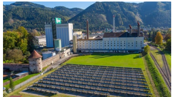
3 Solare Prozesswärme Brauerei Göss (2014) – Der Maischprozess wurde umgestellt und ein 1.470 m 2 Solarthermiekollektor liefert Warmwasser im Niedertemperaturverfahren dank neuem Wärmetauscher – ein österreichischer Beitrag zu IEA SHC Task 49 Solar Heat Integration in Industrial Processes. (Foto: AEE INTEC)
