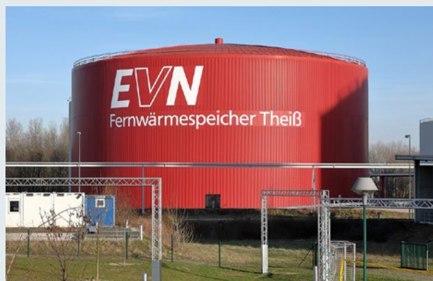
50.000 m 3 -Fernwärmespeicher in Theiß, Foto: C.Stadler/Bwag
