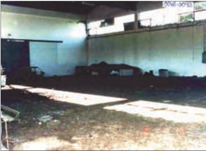
Slika br. 12 Unutrašnjost hangara u objektu Luka.
