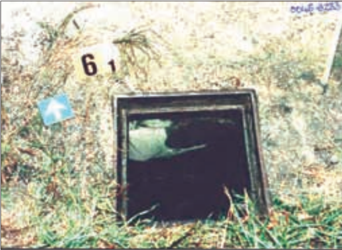
Slika br. 15 Krupni plan šahta u objektu Luka. (Svjedoci su detaljno opisali kako je Jelisić streljao žrtve na način da ih je prisiljavao da stave glavu na šaht).
